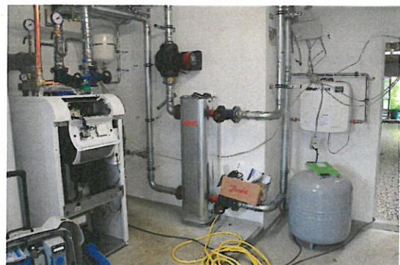
Neue Brennwertheizung und Warmwasserversorgung in der Oscar-Drees-Sporthalle
